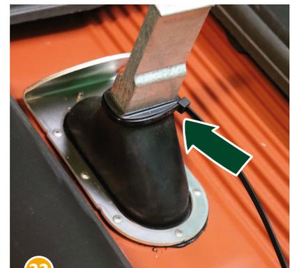
22 Die Oberseite der Dichtmanschette mit Hilfe des Kabelbinders zusätzlich sichern. Hierzu den Kabelbinder in die Nut einpassen, die Lasche des Kabelbinders an einer der vier Ecken der Manschette platzieren, festziehen und den überstehenden Rest abschneiden.
