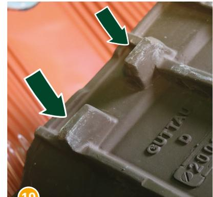
19 Die Verriegelungsnasen auf der Rückseite der einzuhängenden Tonziegel....
