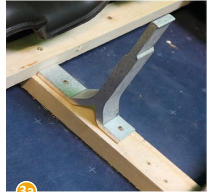
**3a** Konsole mit dem langen Schenkel nach oben an die Dachlatte heranschieben (Dachlatte dient als Orientierungshilfe).
