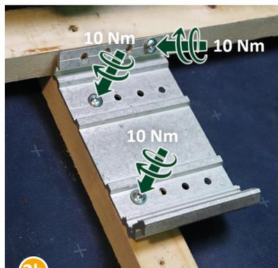
**3b** Alpha-Flex mit der Nut nach oben platzieren. Nach links/rechts versetzt auf der Dachlatte ausrichten und befestigen (mind. 3 Schrauben, 10 Nm).
