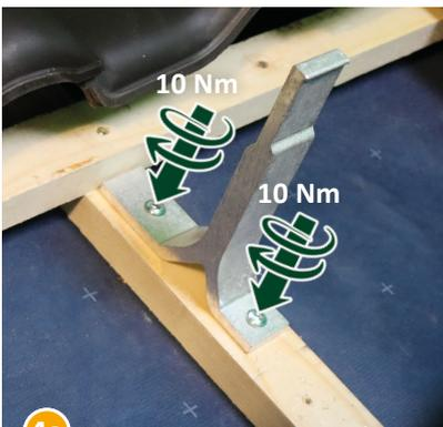
**4a** Konsole befestigen: Position durch Anziehen der Schrauben (mind. 2 Schrauben, 10 Nm) fixieren.
